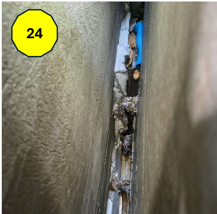
Panoramica su 6 nidi di rondone maggiore, stesi «ad amaca» in un giunto di dilatazione verticale. La torre era ancora frequentata da almeno 3 rondoni, alle ore 21:30 del 10.10.2026. Guido Pinoli e Marco Toffanello,
