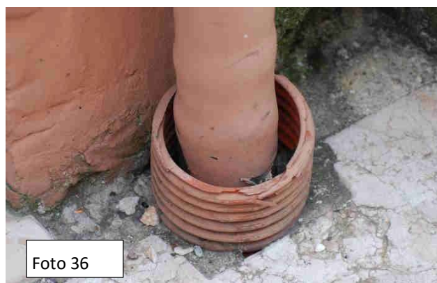
Foto 36 – Lo spazio tra il tubo del gas e la sua guaina è un possibile passaggio per entrare nello stabile.
