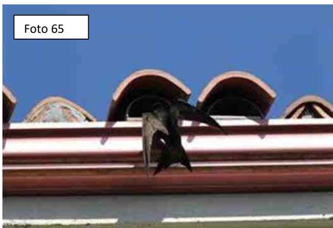
Foto 65 - Un'altra soluzione collaudata e quindi validata, consiste nel realizzare strette cassette nido per rondoni, posizionate in modo che siano appoggiate sulla grondaia e infine coperte da 2 coppi. In tal modo i rondoni non saranno ostacolati dalla grondaia.
